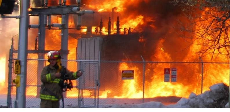
Como mínimo, esto conducirá a grandes aumentos en las pérdidas en el hierro y, por lo tanto, de consumo de energía, en máquinas rotativas y transformadores, así como a mayores pérdidas por corrientes parásitas en los transformadores. En el peor de los casos, incendios en los sistemas de cableado y distribución o incluso una falla catastrófica del transformador.
